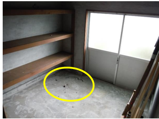
⑥天井のコンクリートが爆裂を起こし、破片が散乱。
