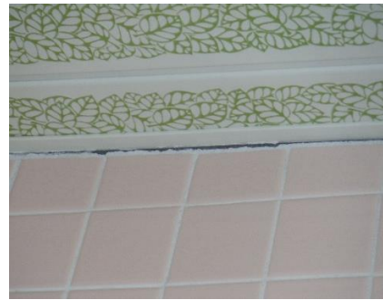
浴室天井と壁の間に割れ目
