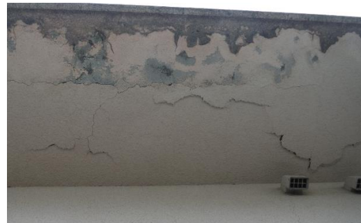
外部庇裏の傷み
