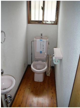
⑤水洗の修理が必要
