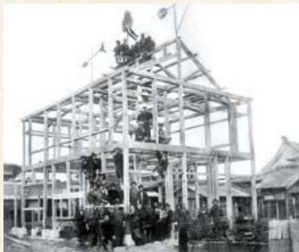
建設中の馬渡写真館。高さ6.7mを誇る近代的な建物で人々から注目を集めた。
