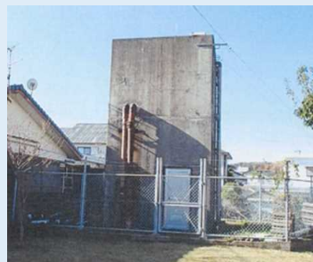
摺ヶ浜配湯施設 高架貯湯槽
