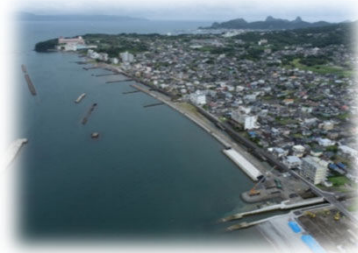
図-14 指宿港海岸整備事業等防災事業の工事の様子
