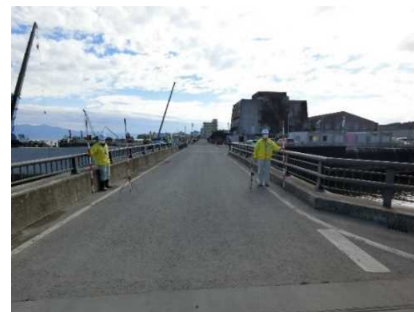
逆瀬川橋現況
