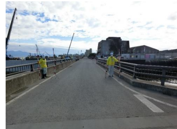
逆瀬川橋現況
