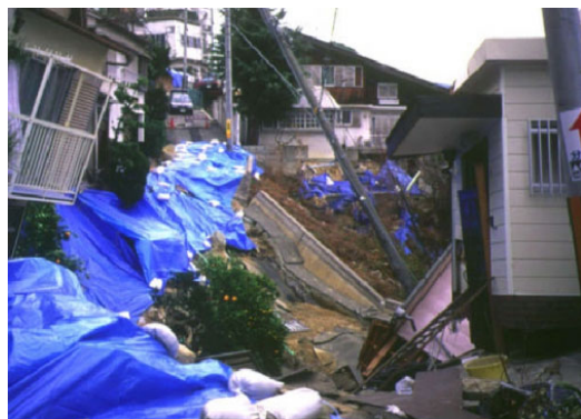
滑動崩落による被害状況（兵庫県南部地震） (国土交通省「わが家の宅地安全マニュアル」より)
