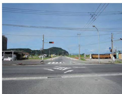
整備中の庁舎湯山線
